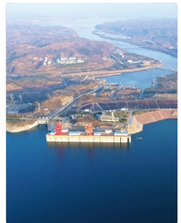
Überwachung der Wasserqualität
