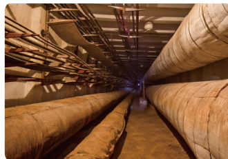
Erfassung unterirdischer Räume
