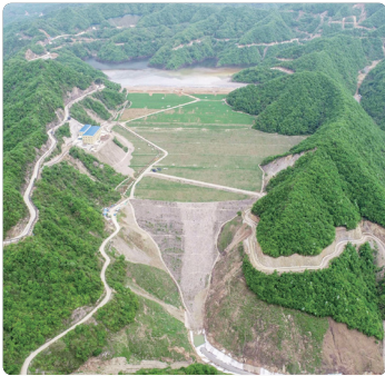
Depósito de relaves
