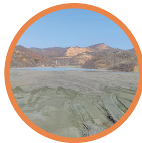
Barrage de retenue
