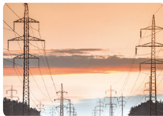
エネルギー設備
